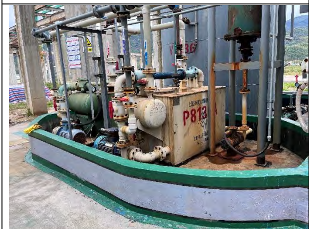
室外设备区围堰
