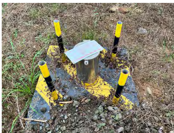
图 4.2-3 地下水监测井
