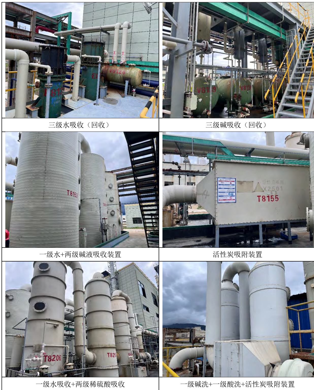
图 4.1-5 废气防治措施现场照片
